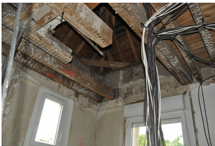
Une trentaine de solives pourries ont dû être remplacées.
