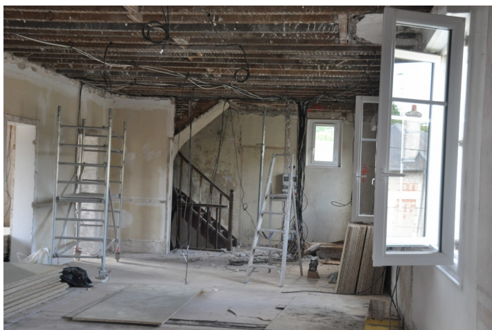
1 er étage côté jardin, cloisons abattues et pose électricité
