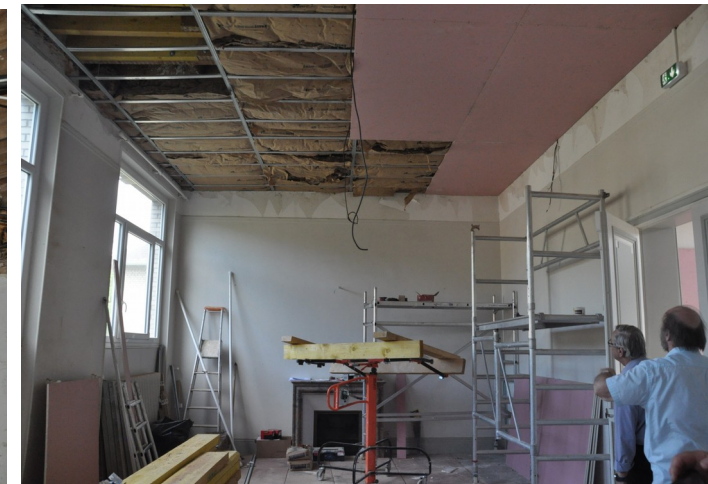
Salle des mariages, plafond abaissé de 25 cm pour créer une protection coupe-feu.
