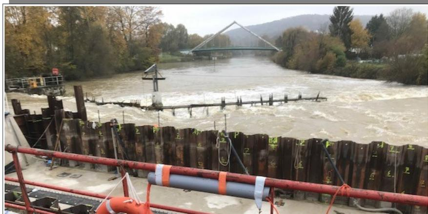
Depuis la passerelle provisoire du chantier (= l'estacade), le groupe a pu voir **l'ancien barrage à aiguilles** en aval du nouveau barrage, avec au fond la passerelle de Soissons/Cuffies. Cet ancien barrage, inventé par l'ingénieur des ponts et chaussées Antoine Poiret, natif de Soissons (1785-1873), disparaîtra donc totalement, après 150 ans environ de bons et loyaux services assurés par de nombreux agents de la société VNF.
